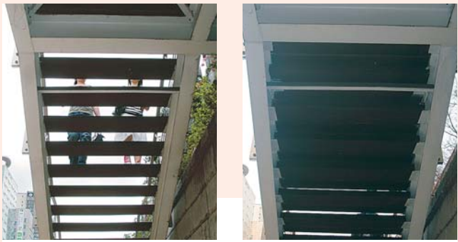
기존의 청계천 계단(왼쪽)과 새로 발판폭을 넓힌 계단의 모습.
